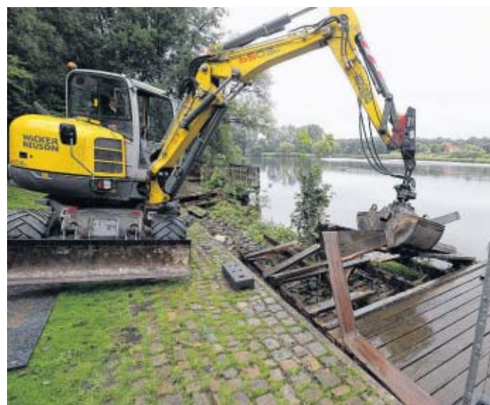
Abgerissen: Die Entenbrücke am Obersee gehört nun zur Vergangenheit. Über eine neue Lösung berät die Politik. FOTO: WOLFGANG RUDOLF
